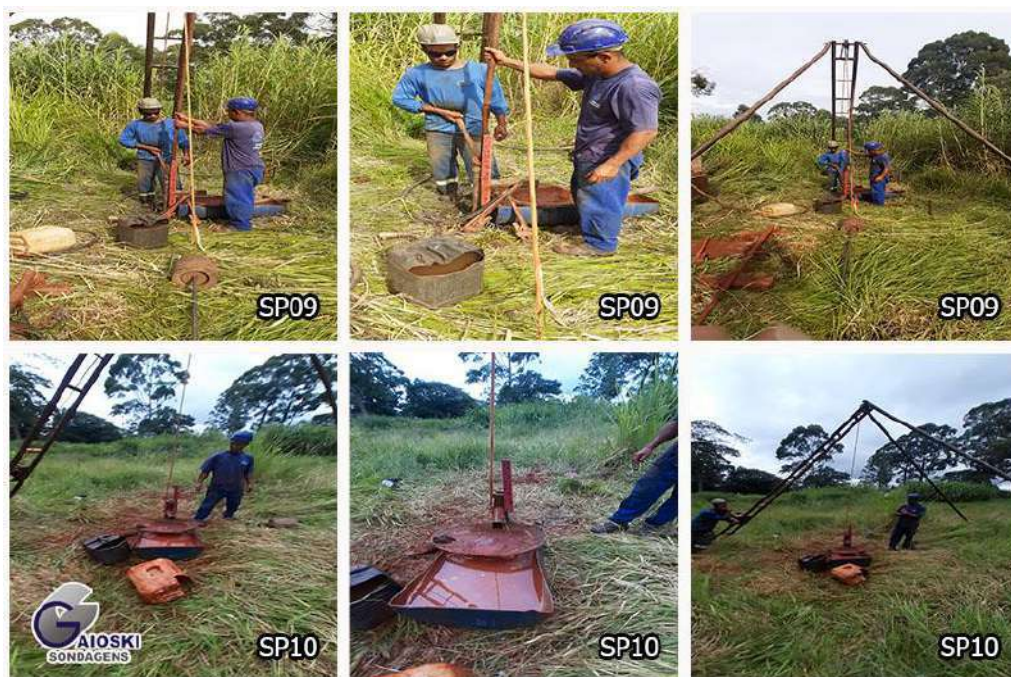
Figura 6: Execução sondagem furos SP09 e SP10 – ENAR ENGENHARIA E ARQUITETURA LTDA
