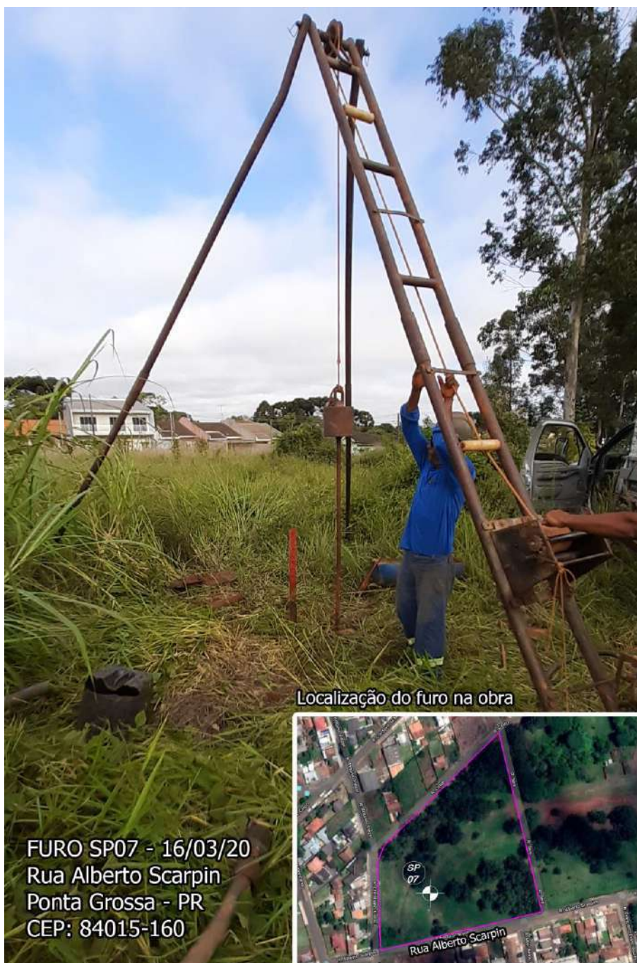
Figura 34: Vista geral da execução do furo SP07 e sua localização
