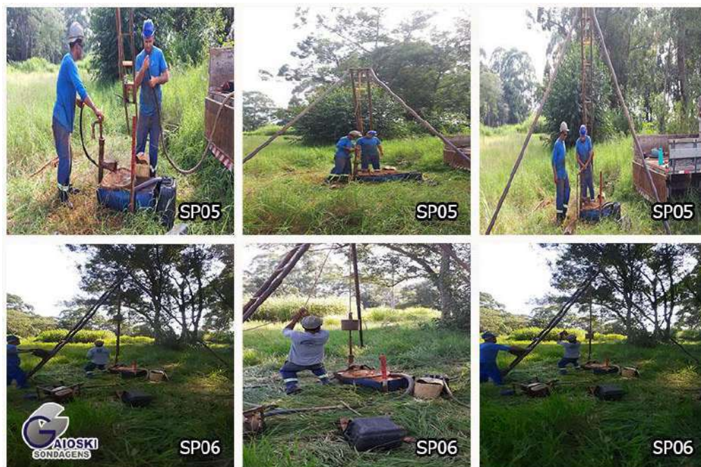
Figura 4: Execução sondagem furos SP05 e SP06 – ENAR ENGENHARIA E ARQUITETURA LTDA
