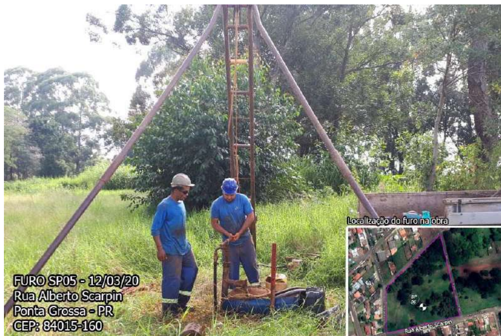
Figura 32: Vista geral da execução do furo SP05 e sua localização
