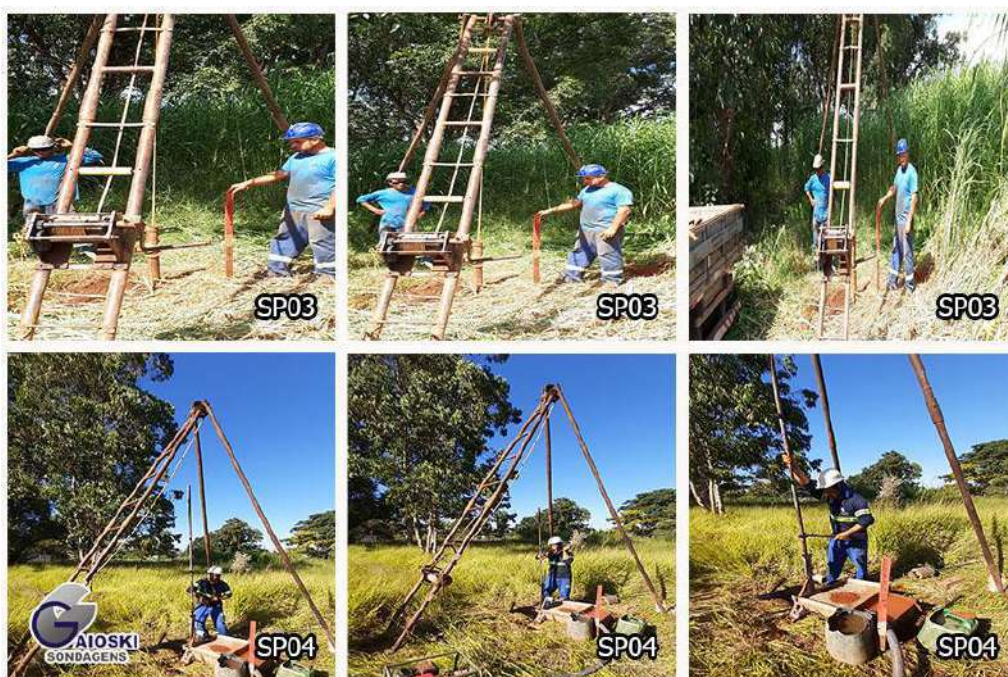
Figura 3: Execução sondagem furos SP03 e SP04 – ENAR ENGENHARIA E ARQUITETURA LTDA
