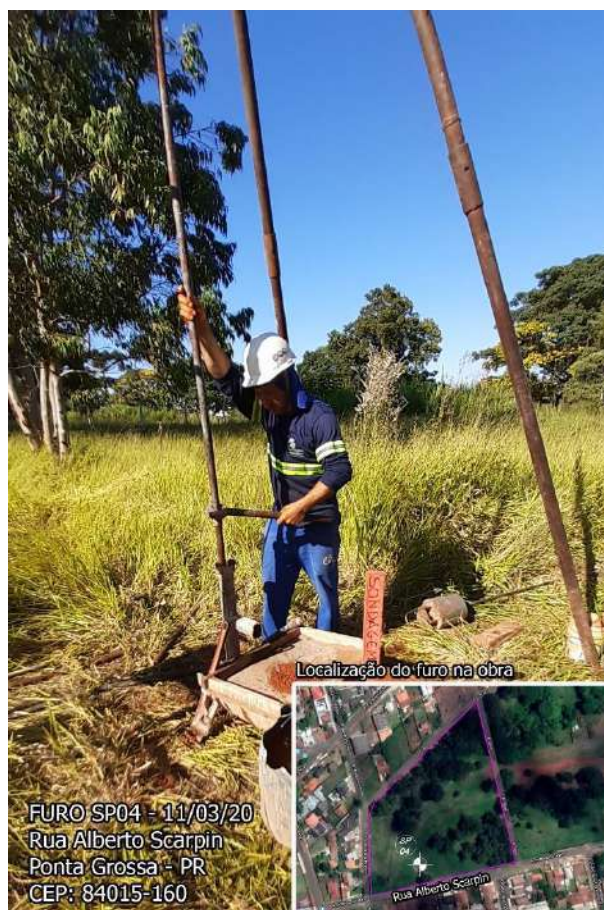
Figura 31: Vista geral da execução do furo SP04 e sua localização
